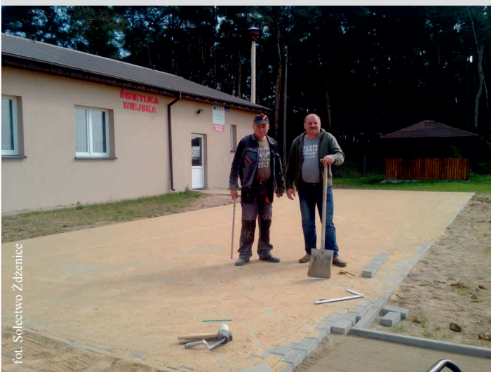
Układanie kostki brukowej przed świetlicą wiejską
